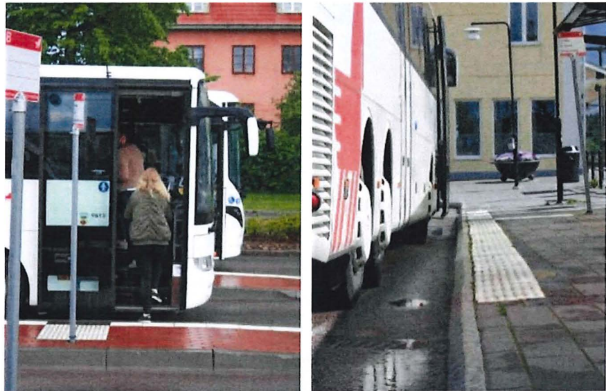
Figur 30: Taktila plattor fanns vid alla busshållplatser men bussarna stannade inte med dörrarna på rätt ställe. Vissa bussar stannade inte heller helt intill kanten.
