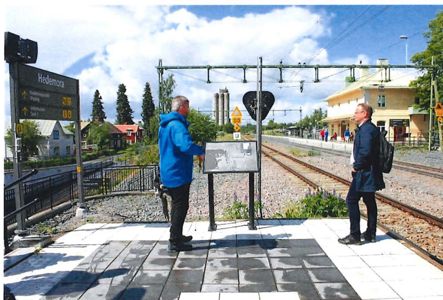
Figur 23: Räcke saknas på plattformen vid spår 2.
