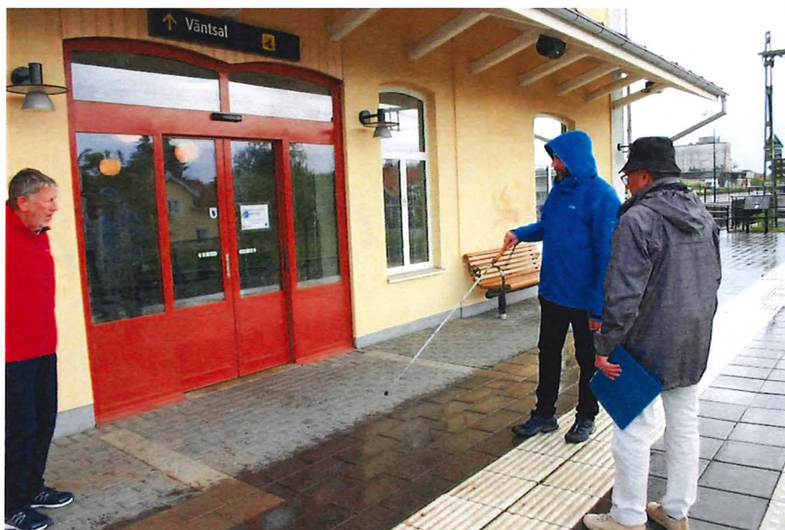
Figur 24: Ledstråket vid spår 1 ger ingen indikation om var man ska gå in i stationshuset.
