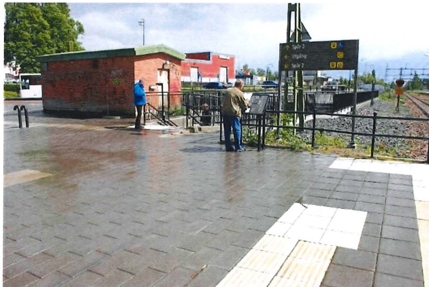
Figur 25: Informationstavla finns i relief och punktskrift för att orientera sig mellan spår 1 och 2 men det saknas ledstråk till och från tavlan.
