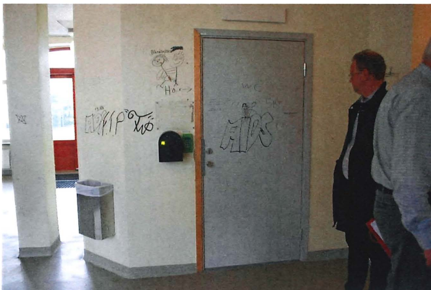
Figur 29: Troligtvis dörren till toaletten. Det saknas information om att detta är en toalett och om hur man ska betala för den.
