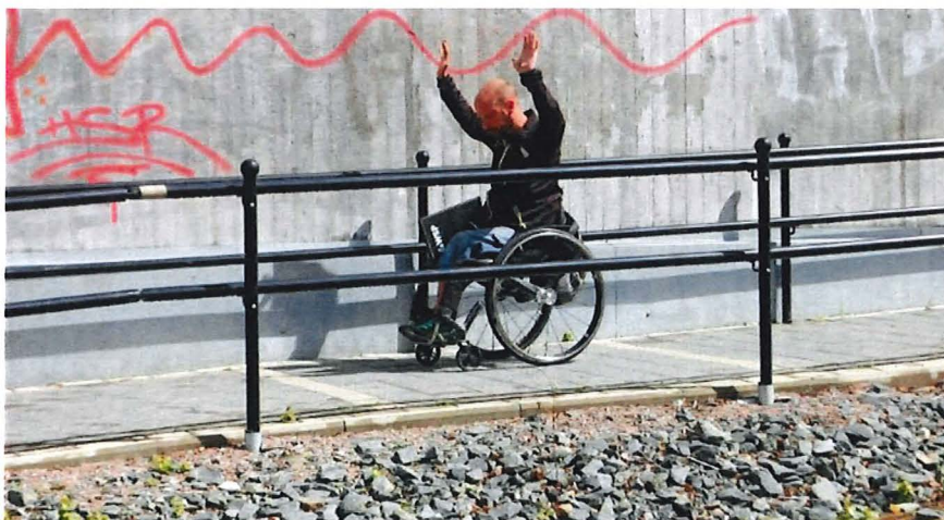
Figur 21: En lång ramp mellan spår 1 och 2 utan platta vilolägen.
